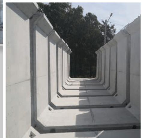
Betonski elementi koji će formirati servisni tunel ispod glavnog tunela, biće pričvršćeni sa FIS EM Plus.
