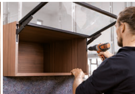
Podešavanje spremnika energije udobno s prednje strane
