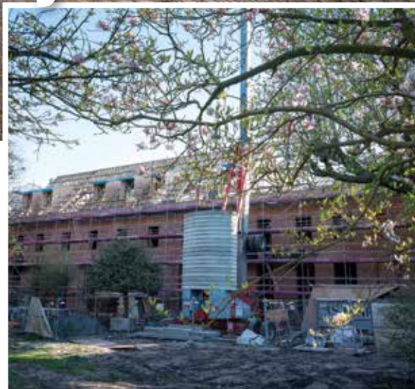
Karmelićanski samostan u belgijskom Brižu nedavno je temeljito obnovljen.
