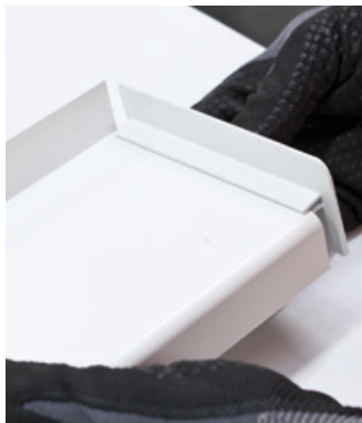
Montaža bočnih alu završetaka
